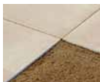
COLOCACIÓN SOBRE ARENA
