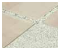
COLOCACIÓN SOBRE GRAVA
